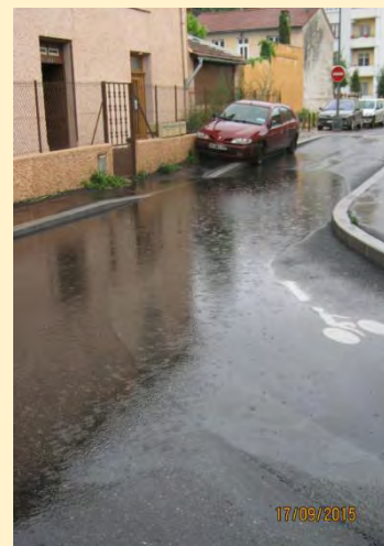
Rue François Jacob après un événement pluvieux et avant décolmatage, Villeurbanne
